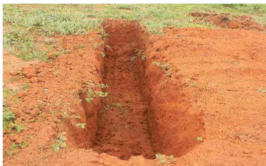
**Foto 3: Valas abertas para auxiliar na retenção de água e proporcionar a recarga do lençol freático.**
